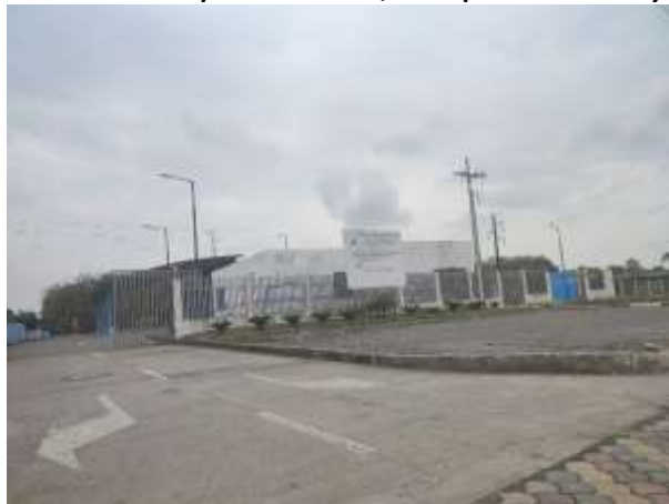
Ilustración 6. Dirección Municipal de Tránsito, Transporte Terrestre y Seguridad Vial
