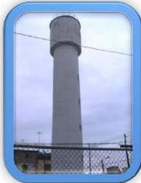
Foto: Tanque Elevado de Bombeo
